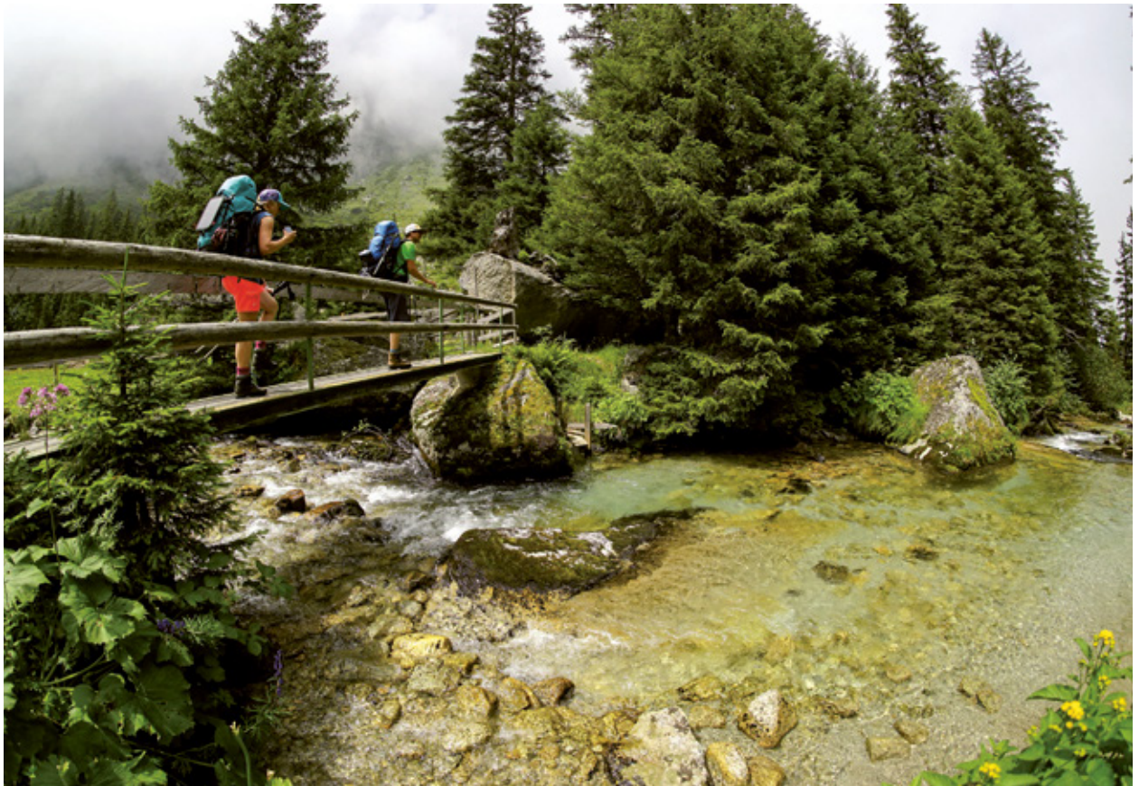
Bauliche Vorrichtungen auf Wanderwegen (Geländer, Handläufe, Brücken, Stege, Treppen, Leitern etc.) gelten als Werke. Es ist wichtig, diese dem jeweiligen Werkeigentümer zuzuordnen, um allfällige Mängel und Schäden melden zu können (Urner Alpenkranz, Fellital, UR).
